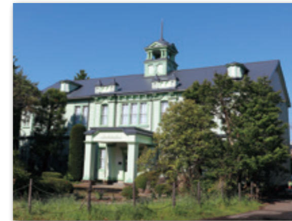
改修された記念館
